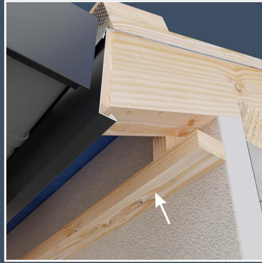
Montage des Befestigungsrahmens für die Laibung.
