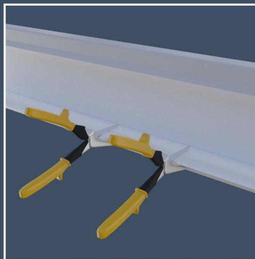
Verwenden Sie einen Metallschneider, um das Abdeckprofil auf beiden Seiten bis zur Biegung hin einzuschneiden.
