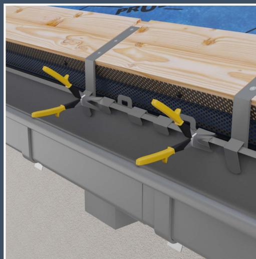
Schneiden Sie die umgebogene hintere Falz links und rechts mit einer Schere ein, um Fixierpunkte am Ablaufstutzen zu schaffen. Dadurch wird ein Verrutschen effektiv verhindert.
